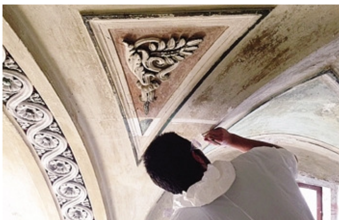
Una fase dei lavori nella chiesa del Carmine di Spirano
