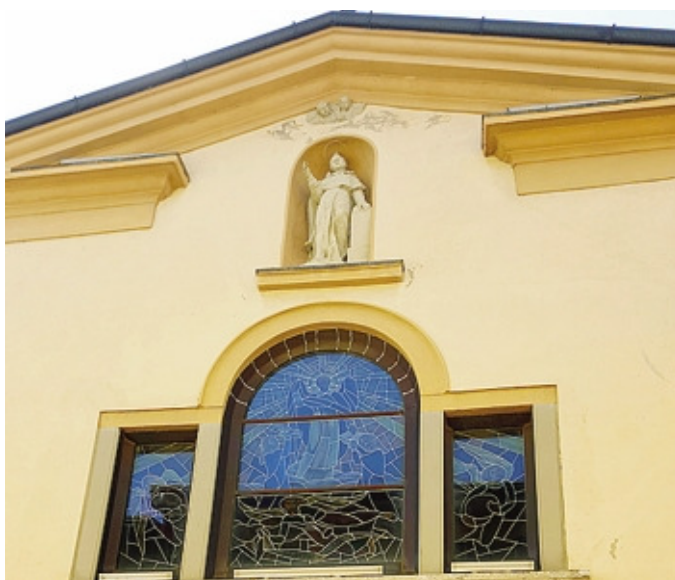
La chiesa dedicata a San Vincenzo Ferreri
