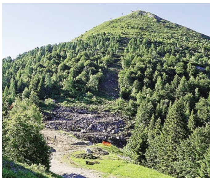
Lavori in corso alla stazione sciistica di Piani di Bobbio-Valtorta
